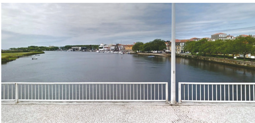
Ponte sobre o Rio Ave
