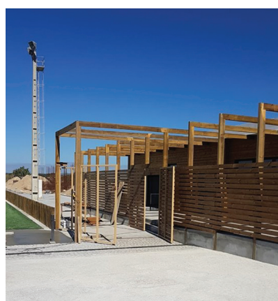
Obras no campo de Aguçadoura
